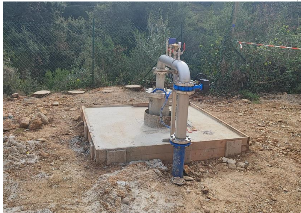
Création d'un forage n° 3
