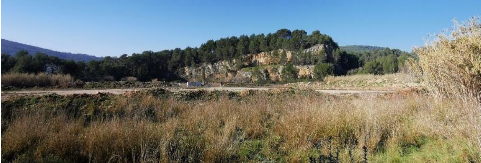
Site de projet au droit de l'ancienne carrière et décharge (GEOENVIRONNEMENT, Février 2023)
