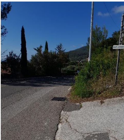
Regard E.P OH1 présent au niveau de la voirie d'accès (GEOTEC, 05/06/2023)
